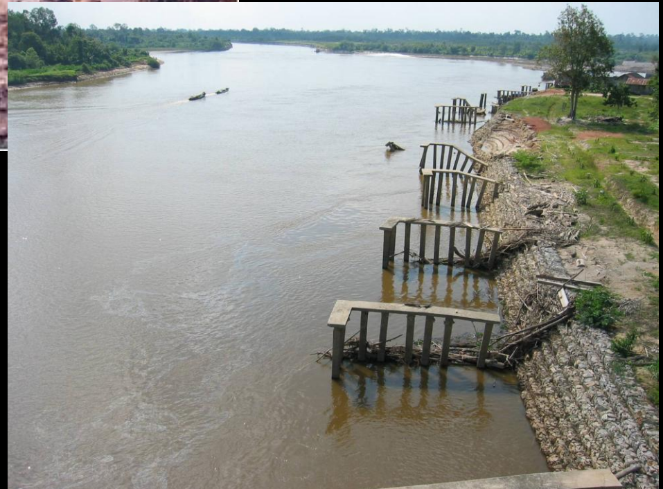
krib permeabel dengan tiang pancang
