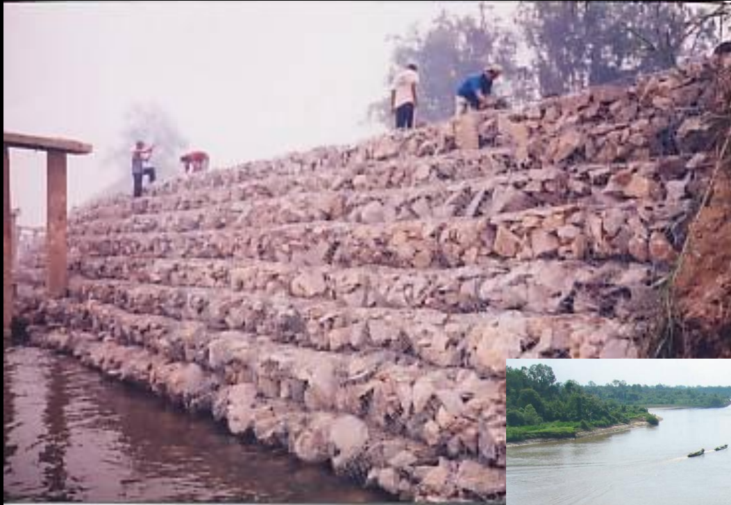
revetment dengan bronjong
