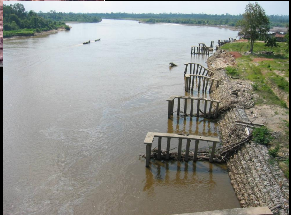
krib permeabel dengan tiang pancang
