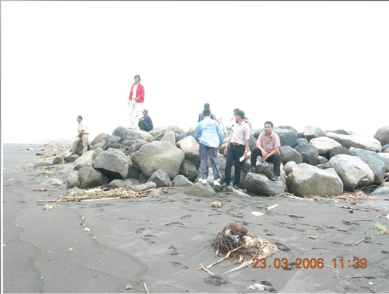
rubble mount jetty di sisi kanan bobot batu lapis lindung 1-2 ton
