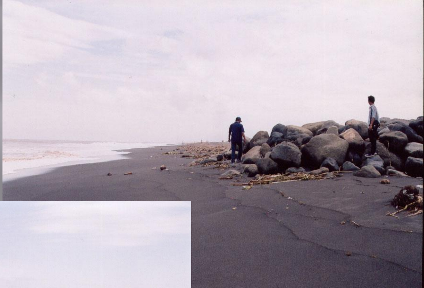
rubble mount jetty di sisi kanan bobot batu lapis lindung 1-2 ton
