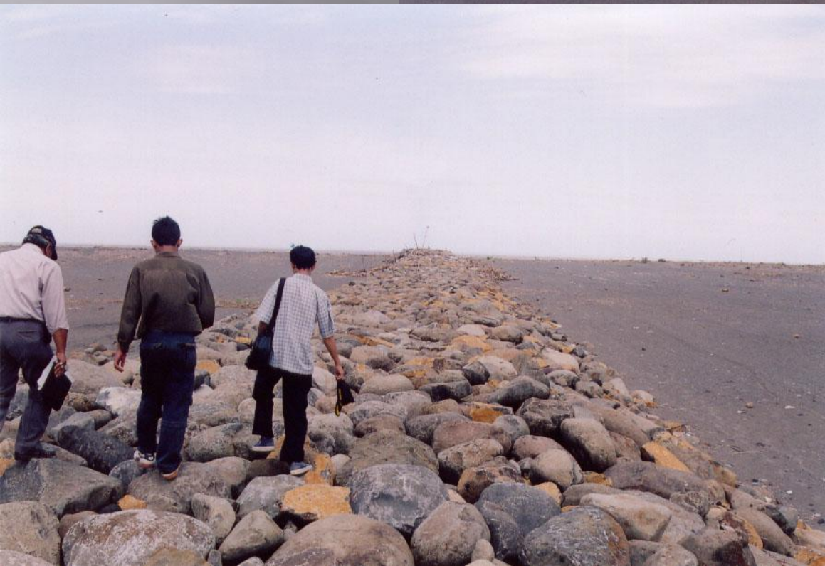
rubble mount jetty di sisi kanan bobot batu lapis lindung 1-2 ton
