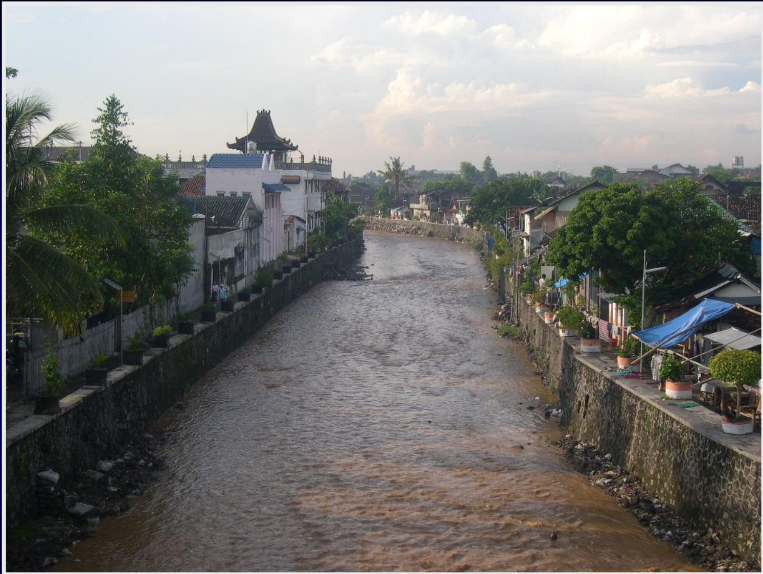
Jembatan Sayidan (arah hilir)
