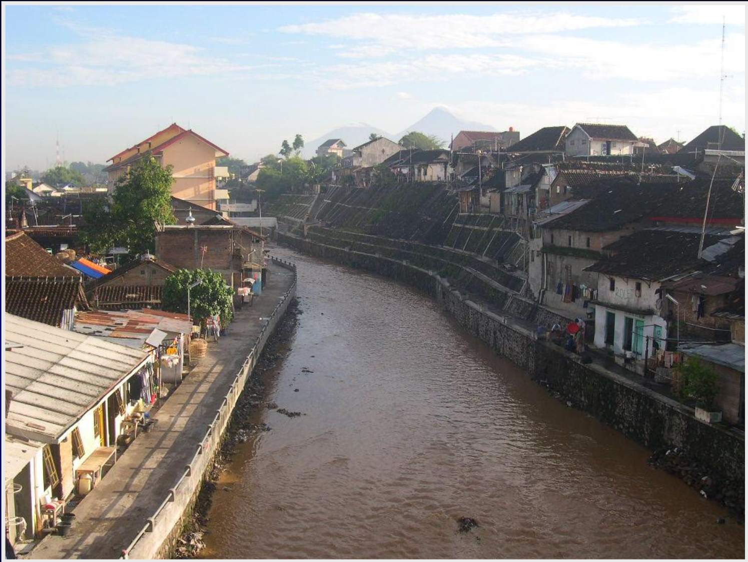
Jembatan Jambu (arah hulu)
