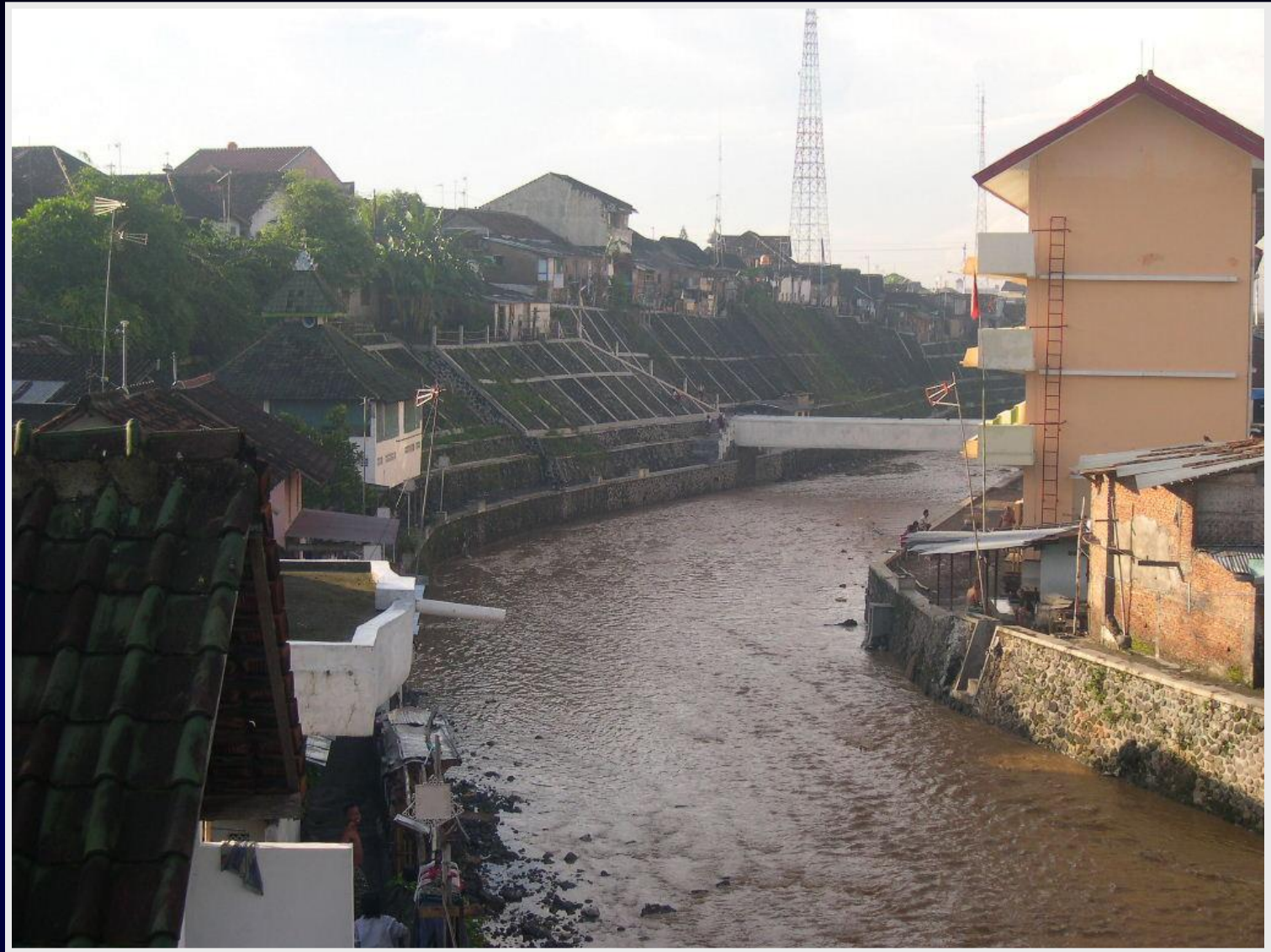
Jembatan Juminahan, Tegal Panggung (arah hilir)
