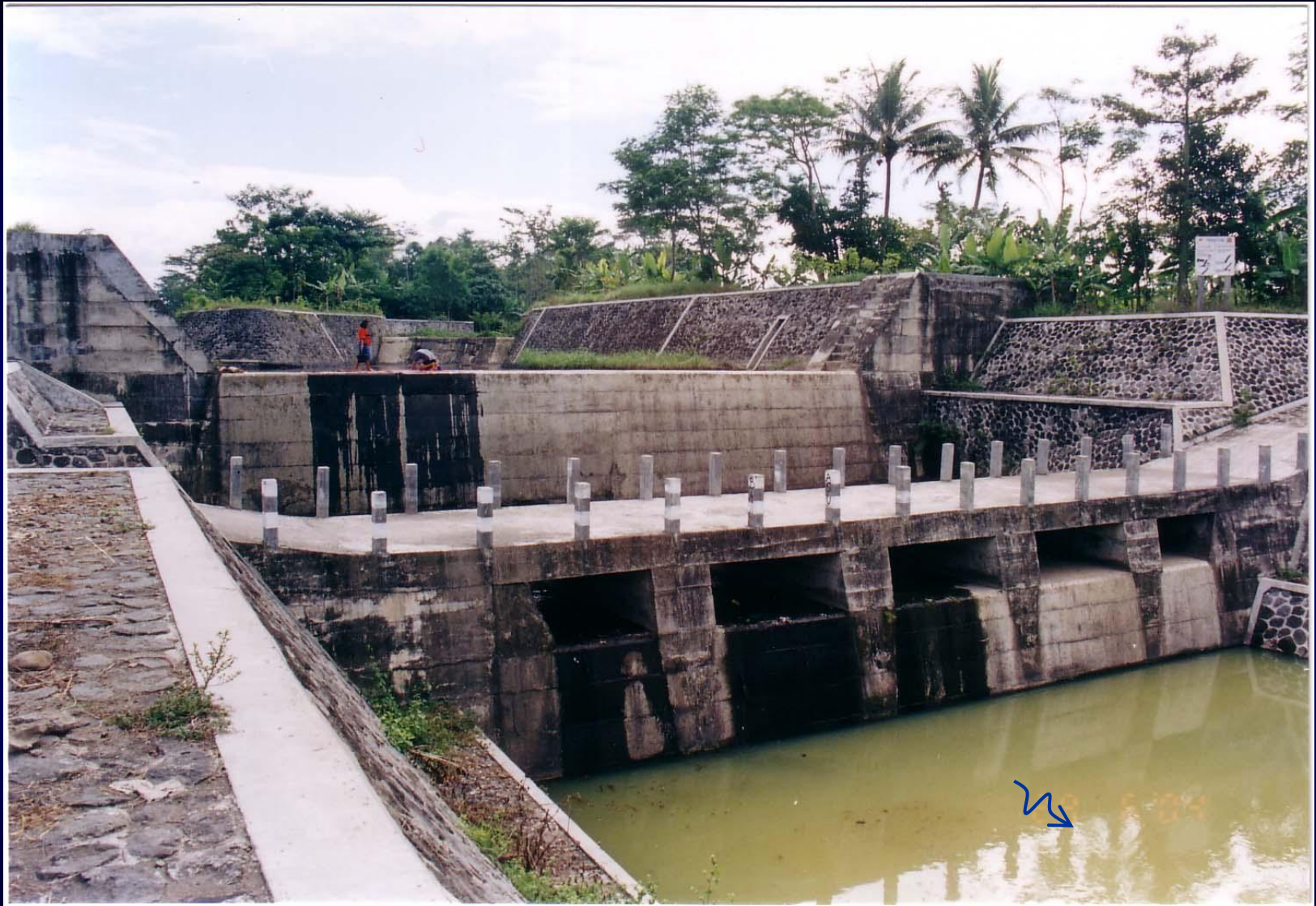
Kanalisisi: groundsill (BO-GS10), tanggul, talud. Groundsill difungsikan pula sebagai jalan.
