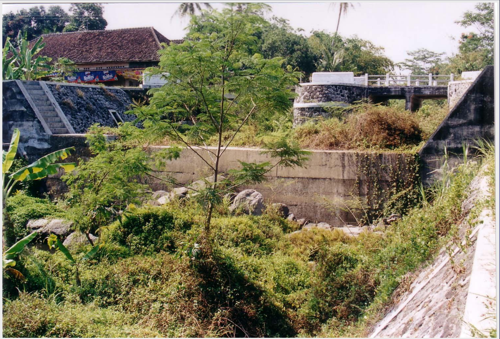
Groundsill BO-GS7, stabilisasi dasar sungai, mengamankan Jembatan Ngaglik di sisi hulu.
