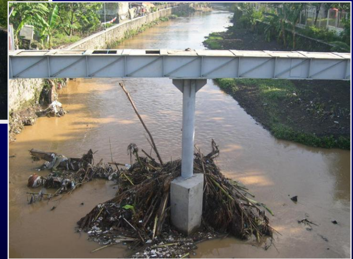
Jembatan Tunggak (arah hulu)
