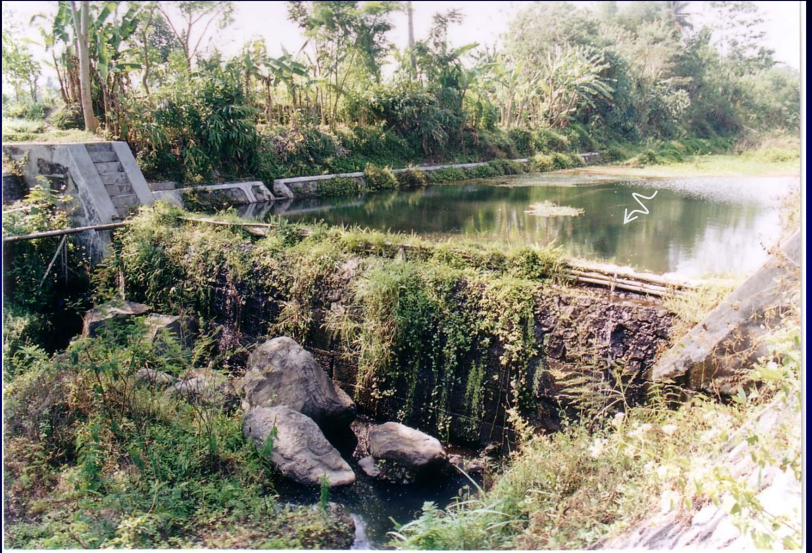
Groundsill BO-GS8, mercu dinaikkan dengan bambu untuk menampung air.
