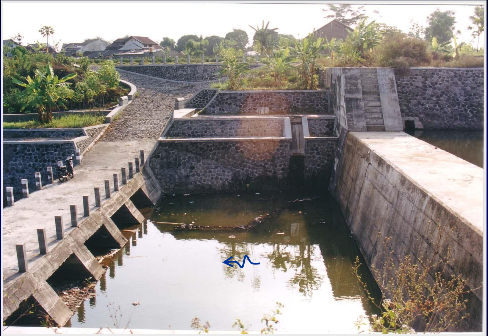
Groundsill BO-GS10, difungsikan pula sebagai jalan.
