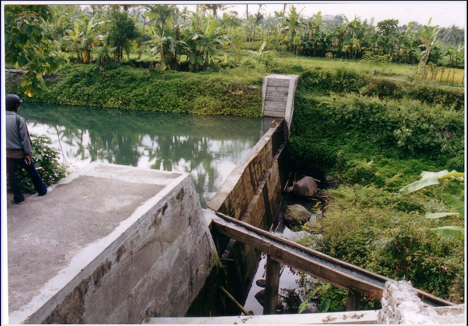
Groundsill BO-GS5, mercu ditinggikan untuk menaikkan muka air dan menampung air.
