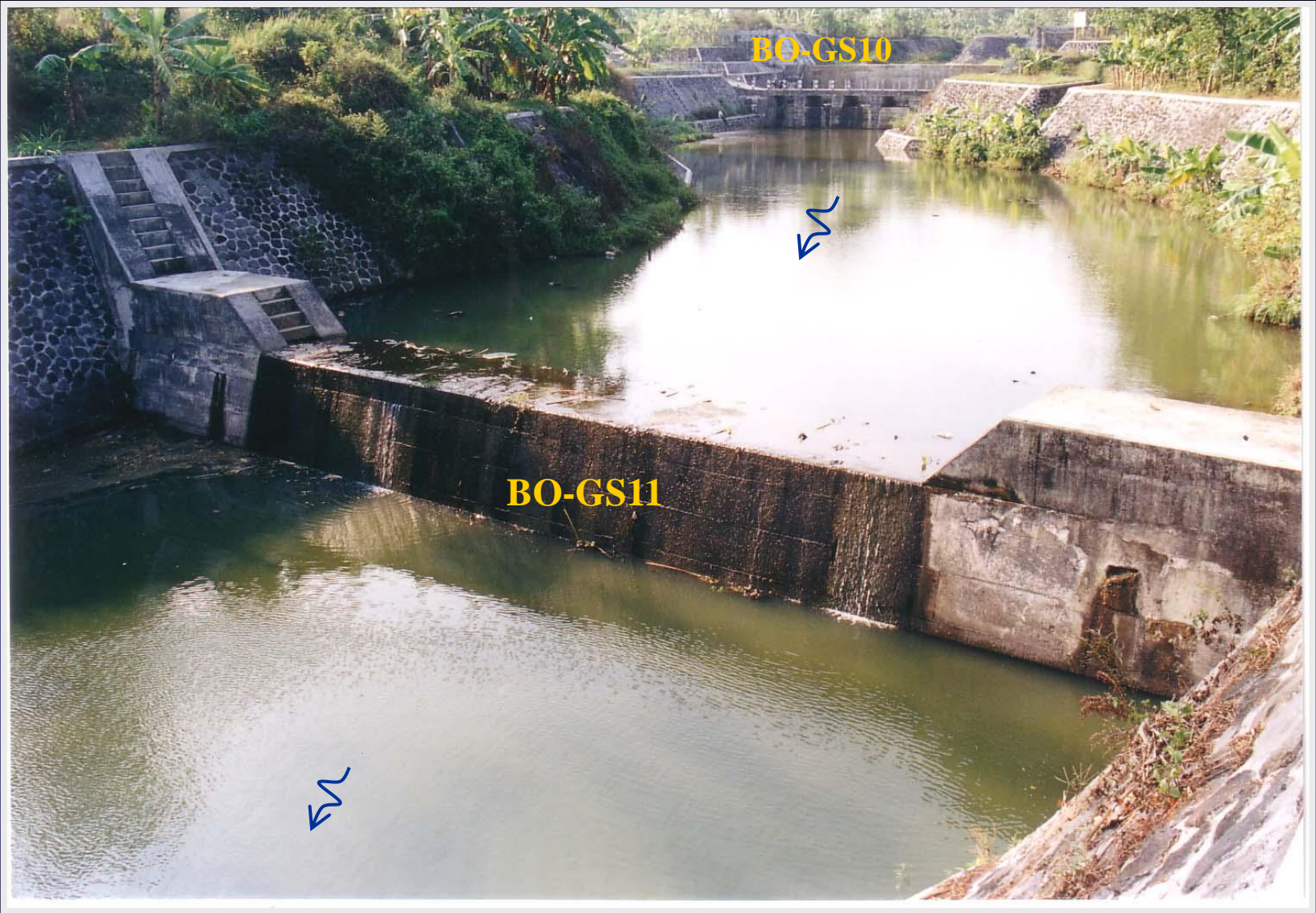
Groundsill BO-GS11 di latar depan dan BO-GS10 di latar belakang
