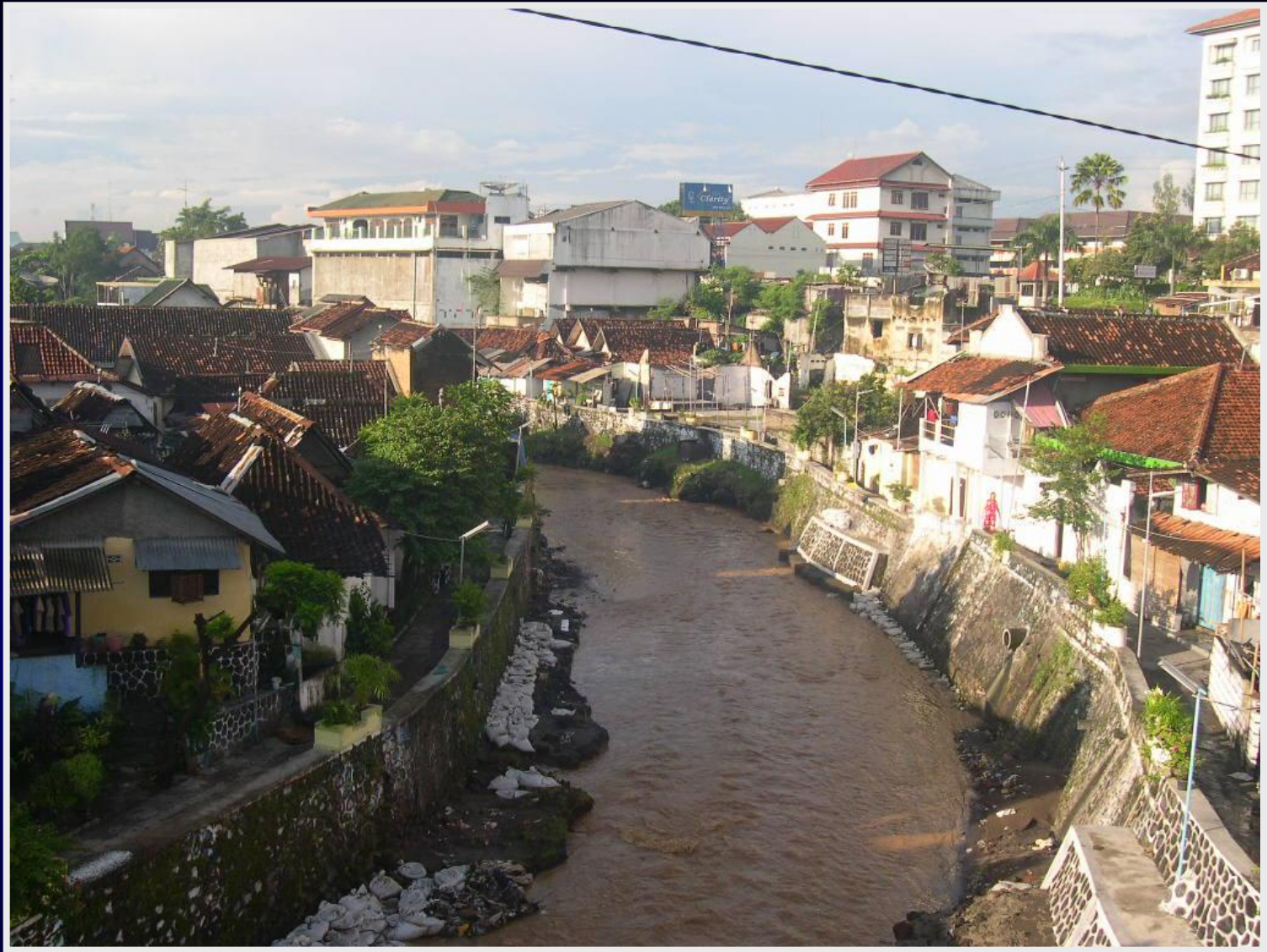
Jembatan Jambu (arah hilir)
