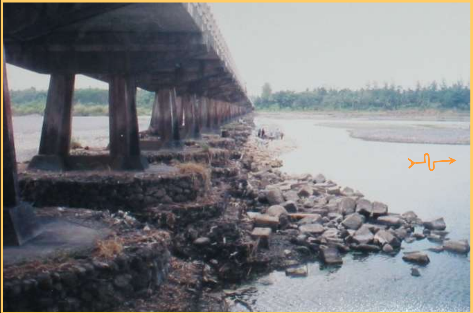
Selimut dan lantai hilir, konstruksi bronjong.
