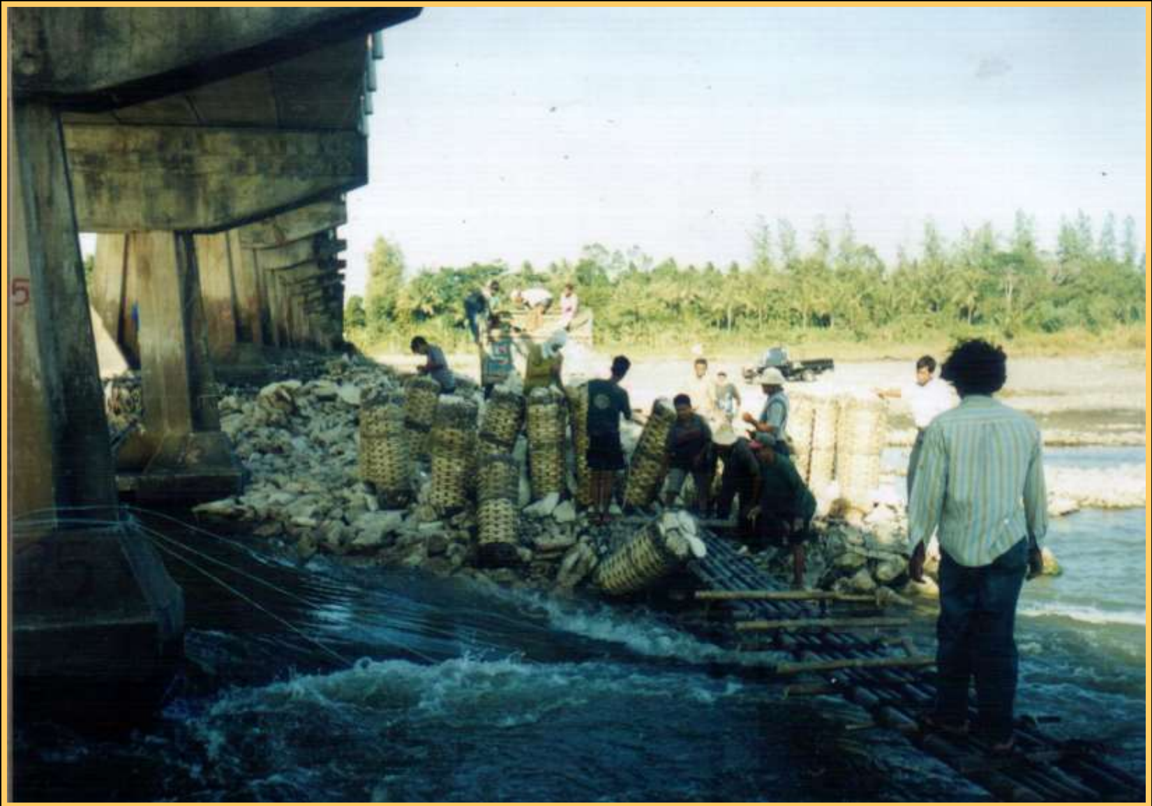
Pelaksanaan perlindungan pilar dengan konstruksi brongjong.
