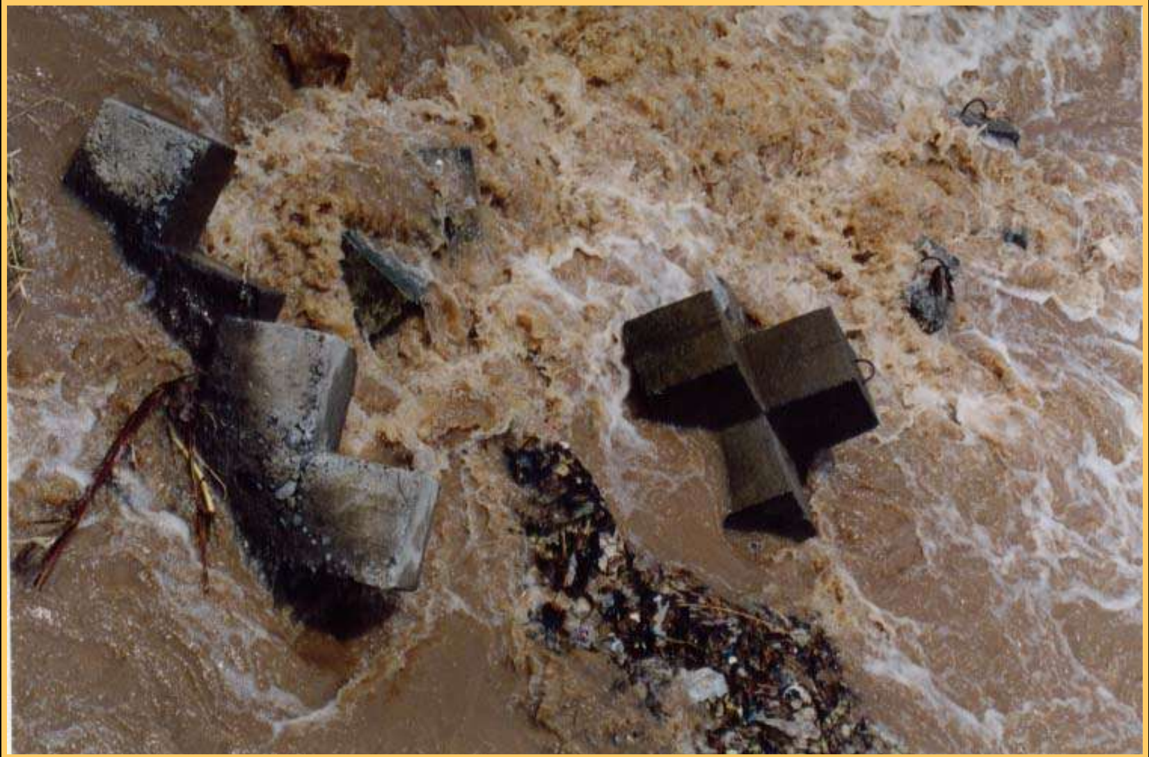
Tetrapod di hilir jembatan untuk perlindungan pilar.
