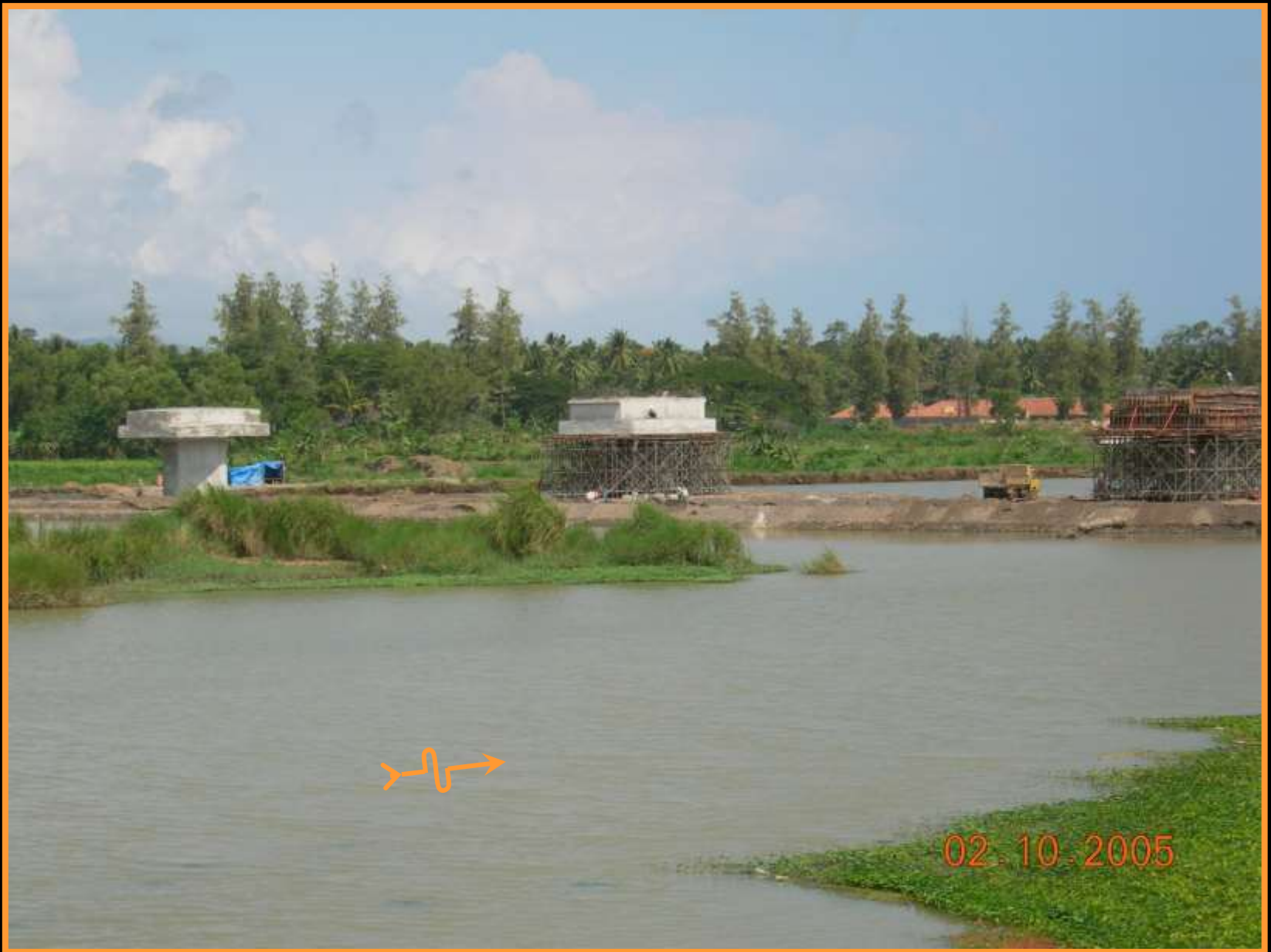
Pembangunan jembatan baru di hilir jembatan lama. Jembatan Srandakan Istiarto
