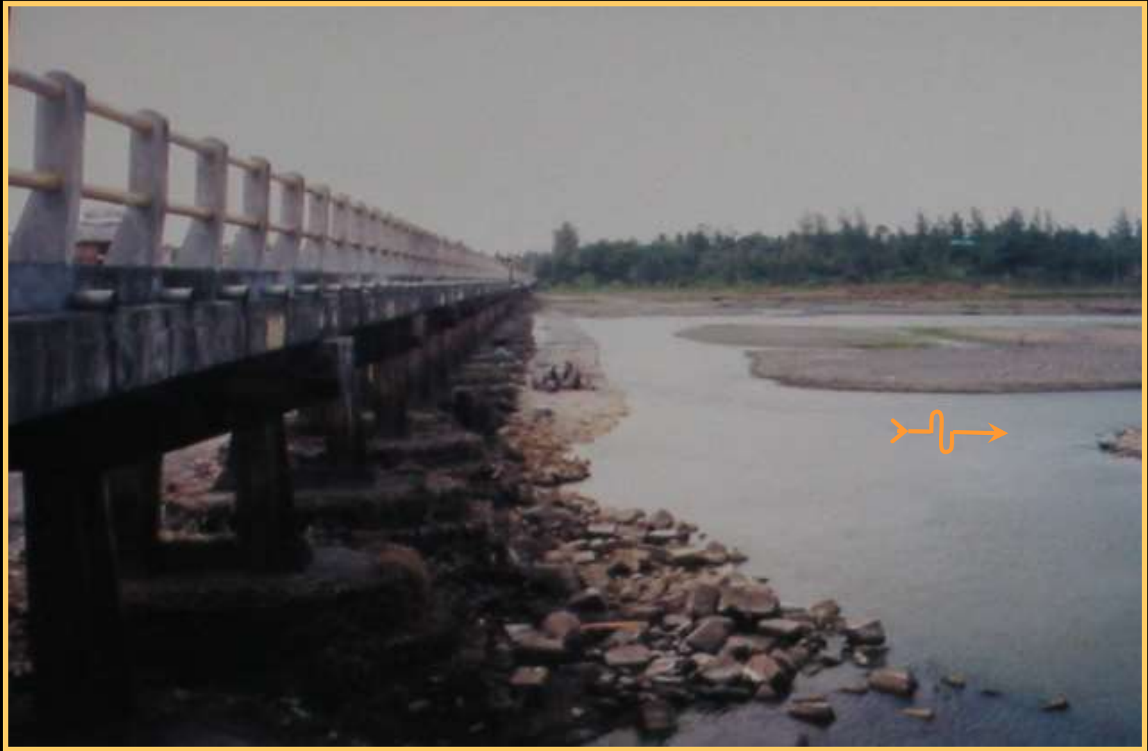
Selimut dan lantai hilir, konstruksi bronjong.
