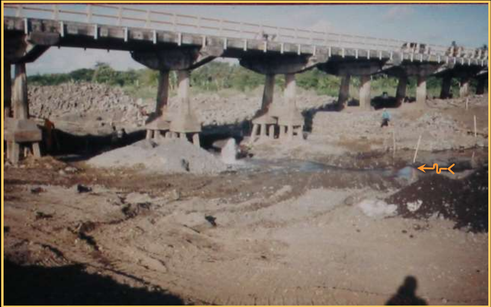
Usaha perlindungan pilar jembatan dengan selimut bronjong.
