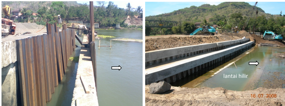
Gambar 9: Rehabilitasi ground sill pengaman Jembatan Kretek yang menunjukkan penambahan sheet pile baja di sisi hilir sheet pile beton lama (gambar kiri) dan lantai hilir beton (gambar kanan).
