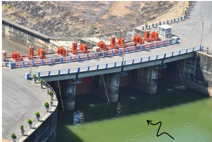
Spillway dengan empat pintu radial untuk mengendalikan banjir
