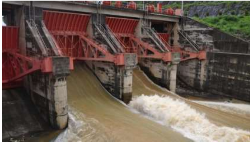
Spillway dengan empat pintu radial untuk mengendalikan banjir
