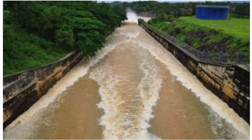
Spillway dengan empat pintu radial untuk mengendalikan banjir
