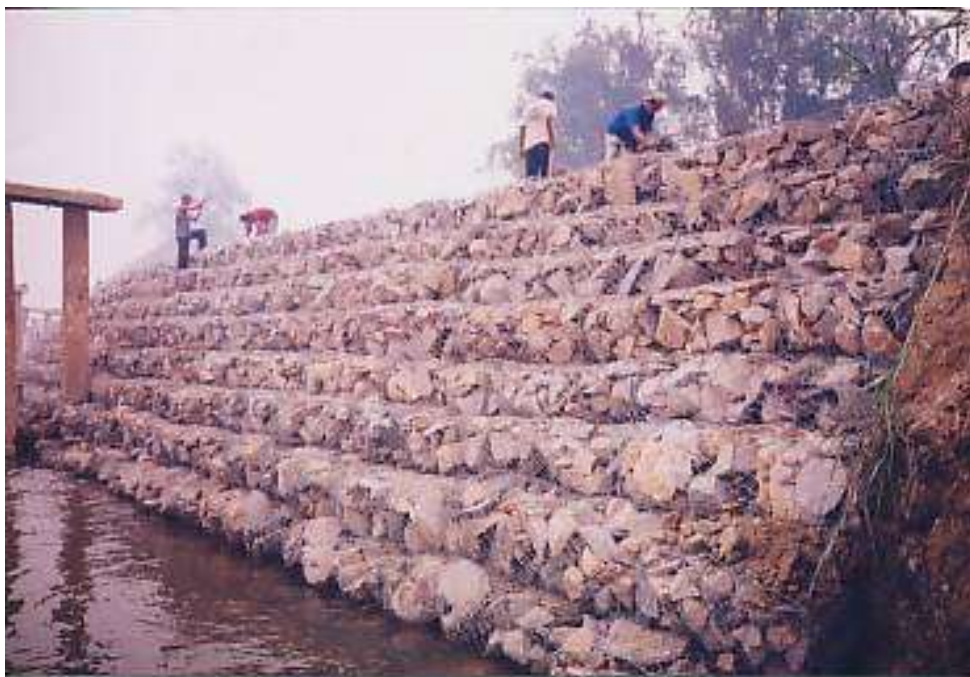
revetment dengan bronjong
