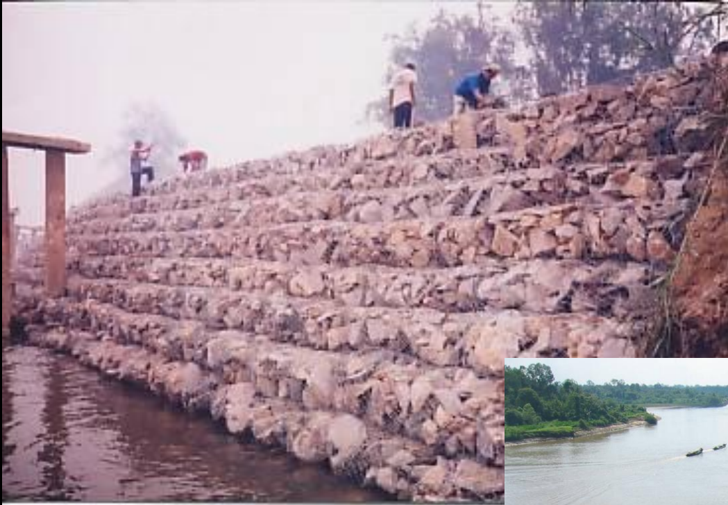
revetment dengan bronjong
