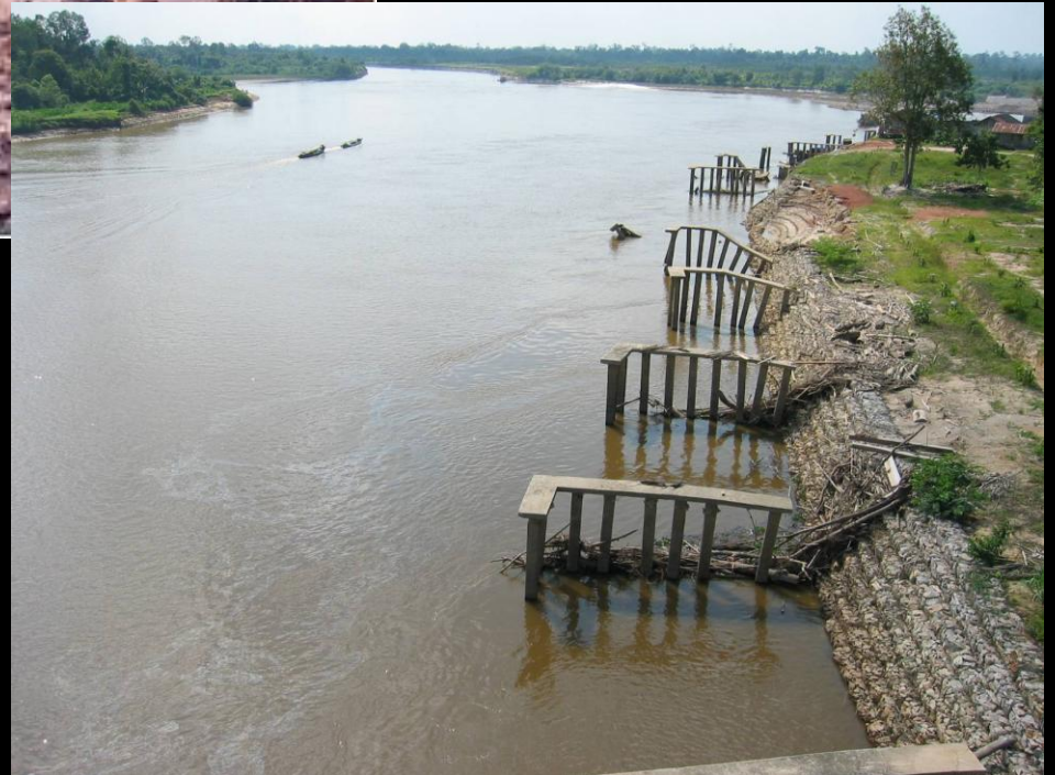
krib permeabel dengan tiang pancang
