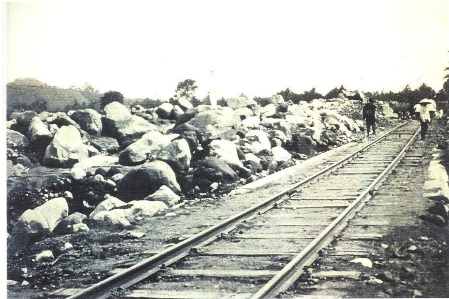
Photo. 19 : Voie ferrée recouverte par un lahar de la K. Batang en 1931 (Cliché : De Kröon d Harloff)
