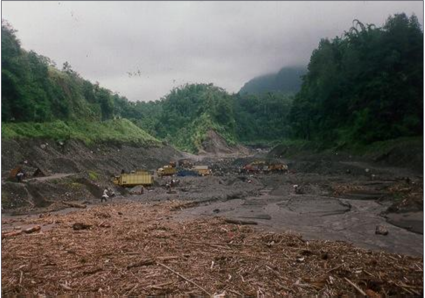
Penambangan di Dam Penahan Sedimen K. Boyong BO-D6, 27-Jan-2003
