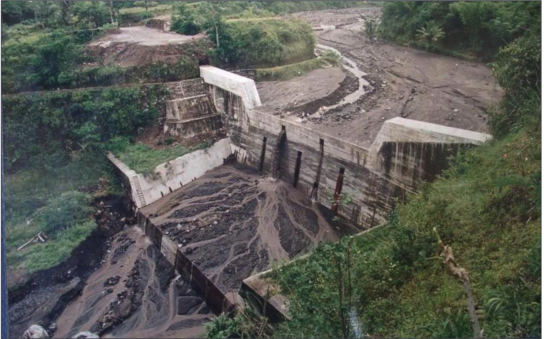
Dam Pengendali Sedimen di K. Boyong BO-D4
