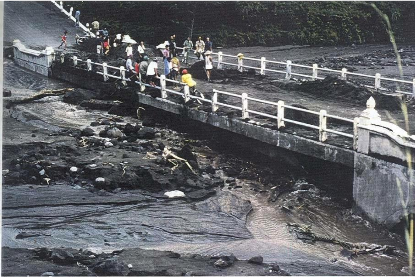
Photo. 47 : Pont de la K. Boyong recouvert par les dépôts de lahar du 3/031995.
