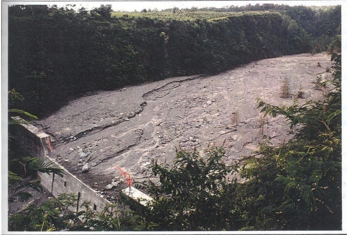
Photo. 21 : Détecteur de lahar installé sur le BOD6, K. Boyong.
