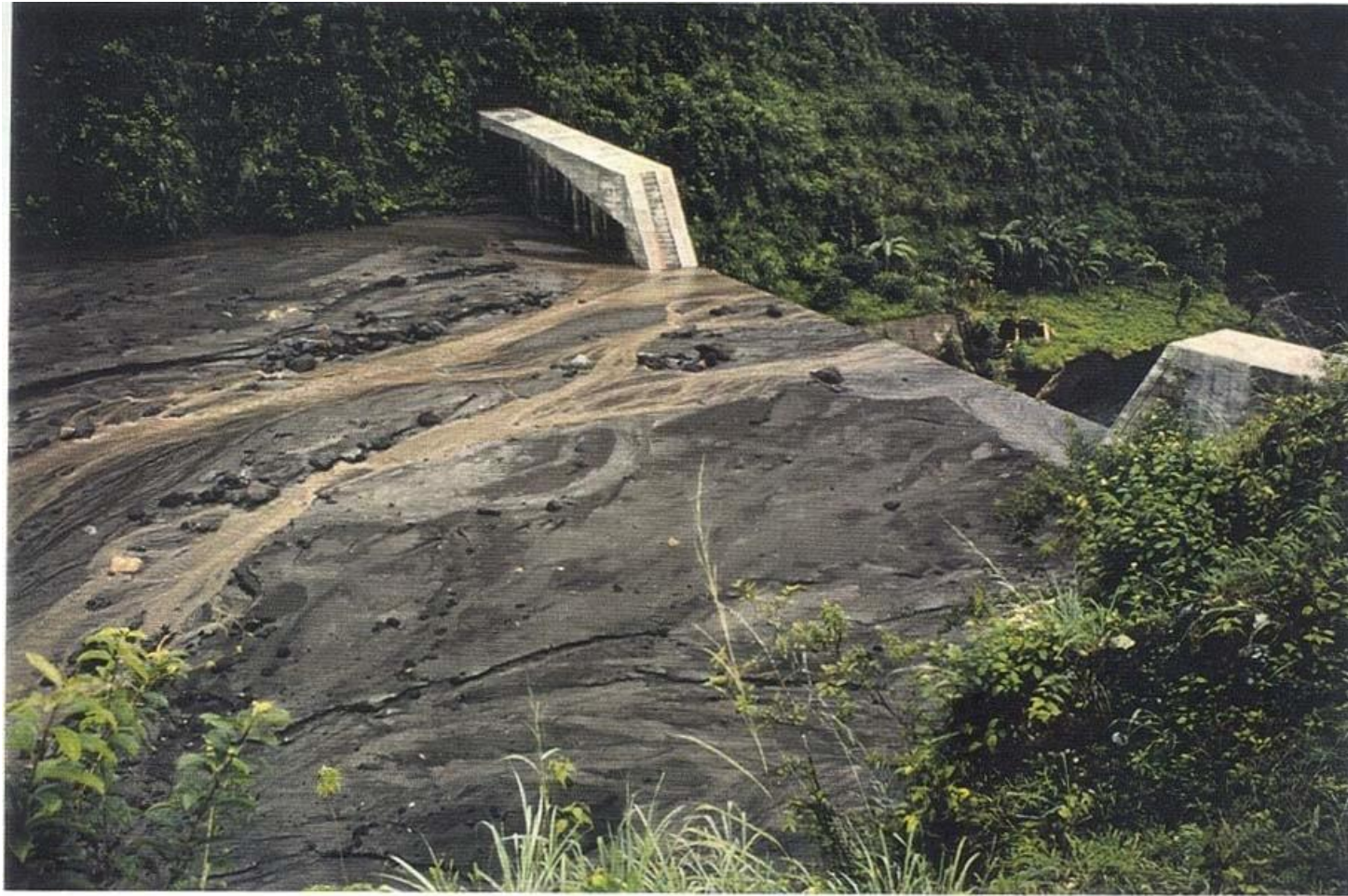
Photo. 33 : Le Sabo dam BOD4 au lendemain du lahar du 19/02/1995.
