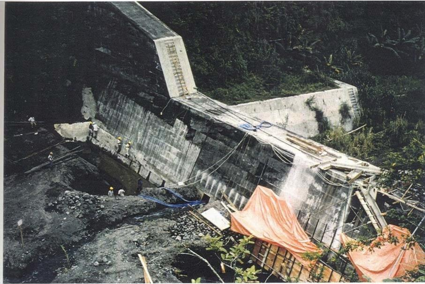
Photo. 32 : Elévation du Sabo dam BOD4 (K. Boyong) en décembre 1994.
