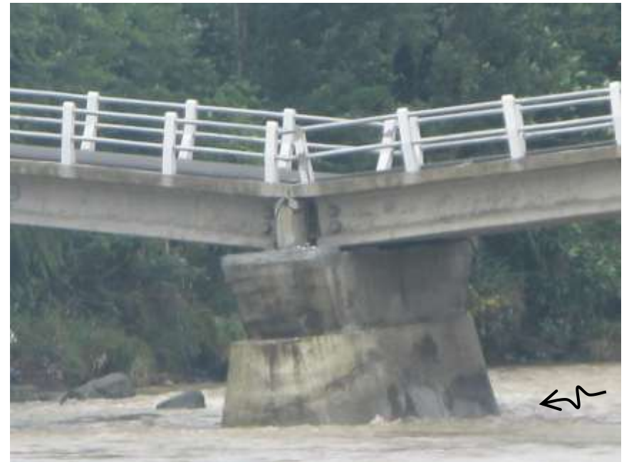
Jembatan Trinil, Magelang (2010)
