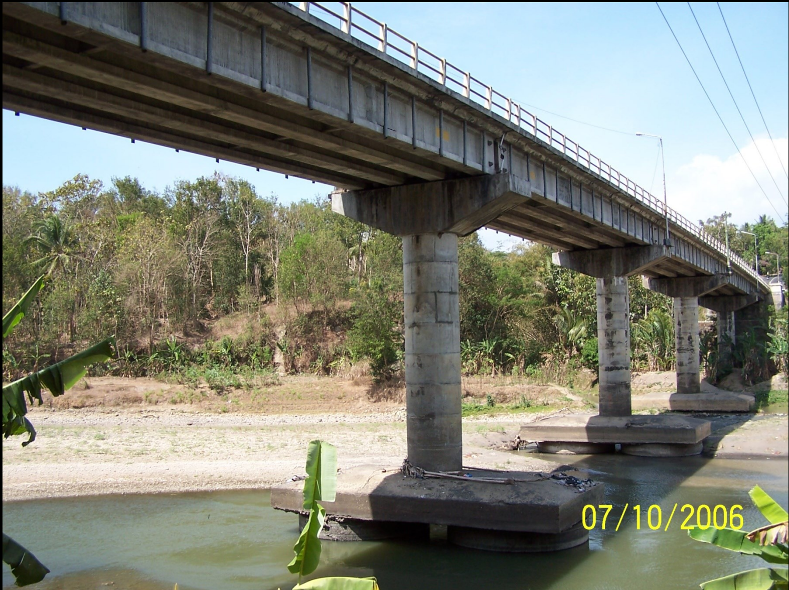
Keadaan pilar dan fondasi jembatan pada akhir musim kemarau 2006.
