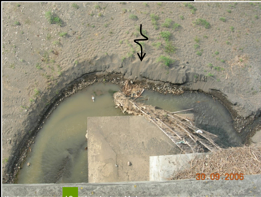
Jejak gerusan lokal di sekitar fondasi jembatan (September 2006).
