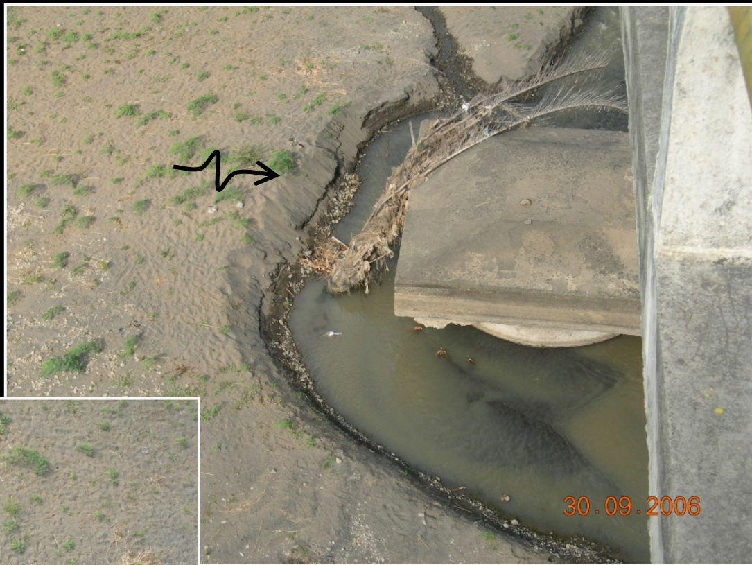
Jejak gerusan lokal di sekitar fondasi jembatan (September 2006).
