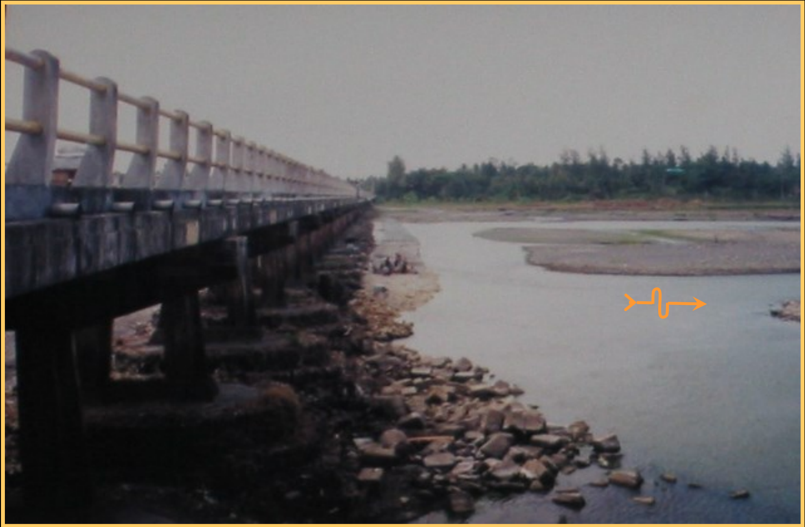
Selimut dan lantai hilir, konstruksi bronjong.
