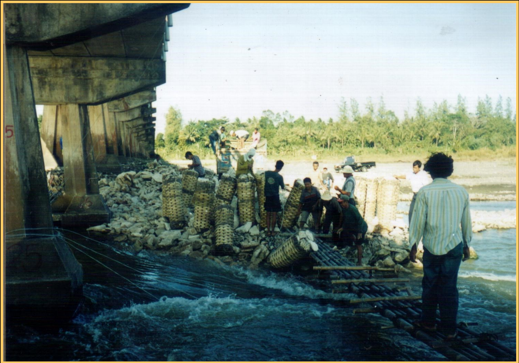
Pelaksanaan perlindungan pilar dengan konstruksi brongjong.
