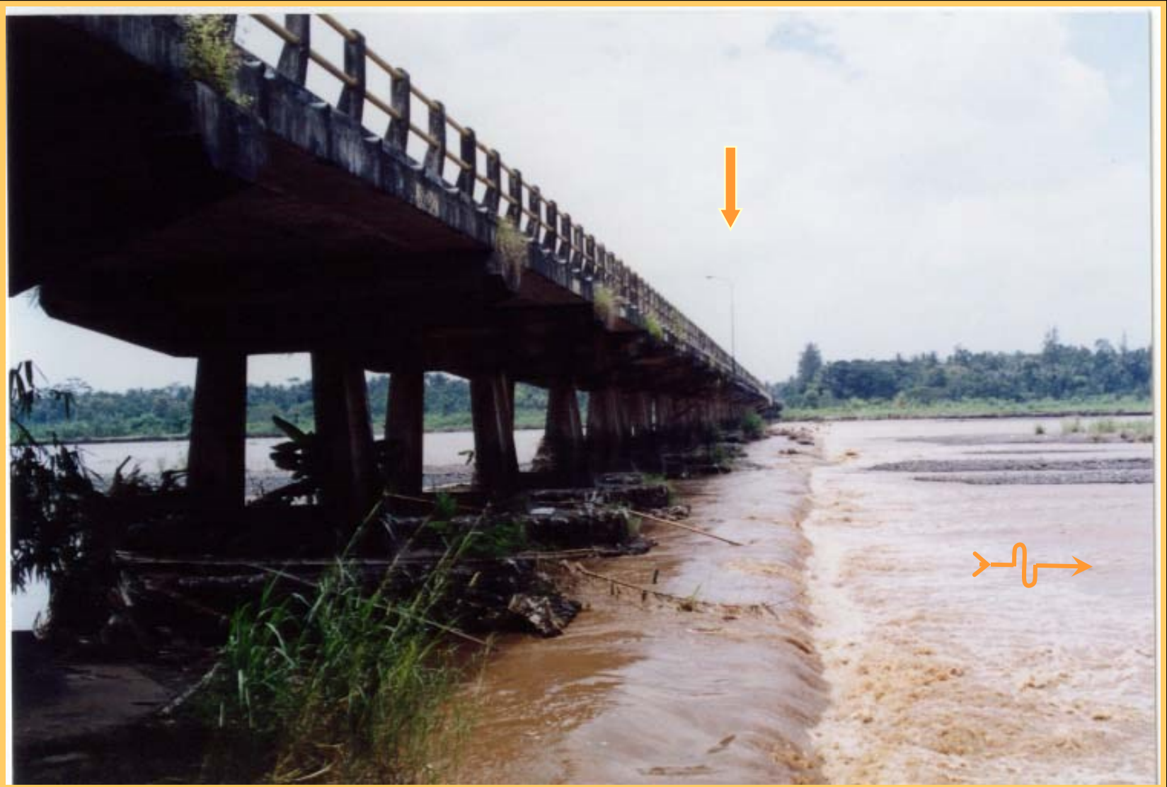
Lantai hilir dengan bronjong dan tetrapod beton, dibangun kembali sekitar November 2002.
