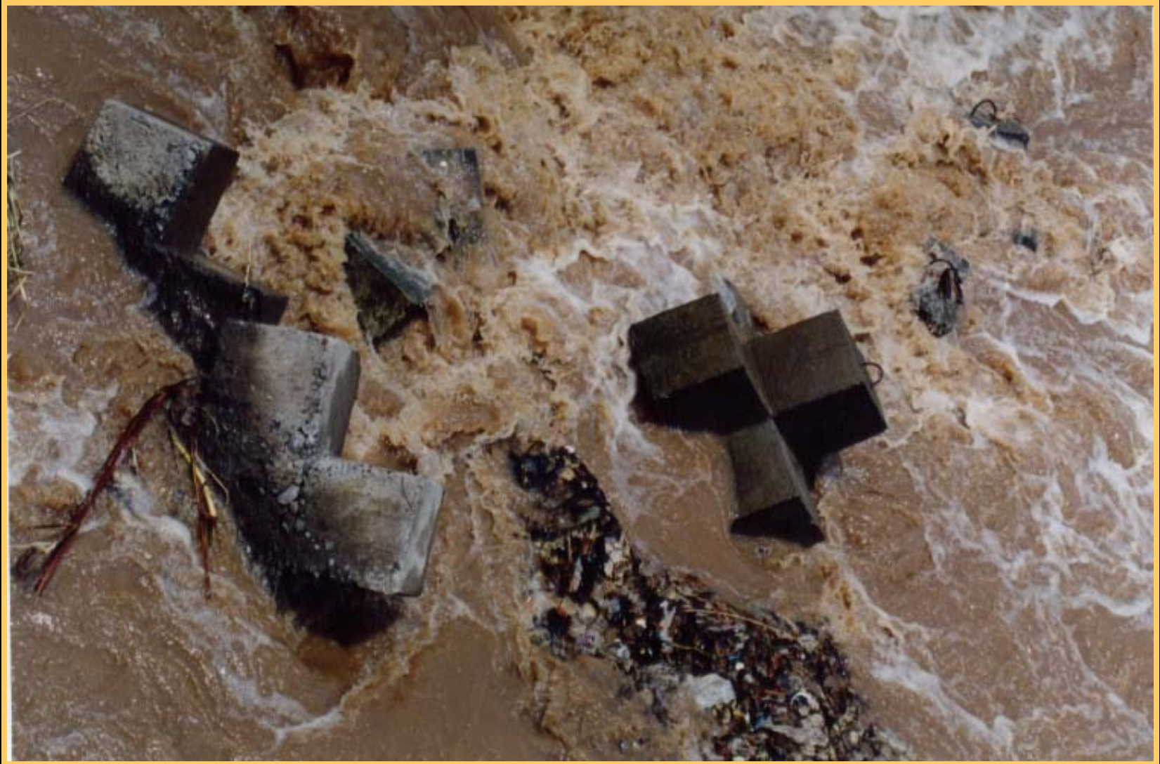
Tetrapod di hilir jembatan untuk perlindungan pilar.
