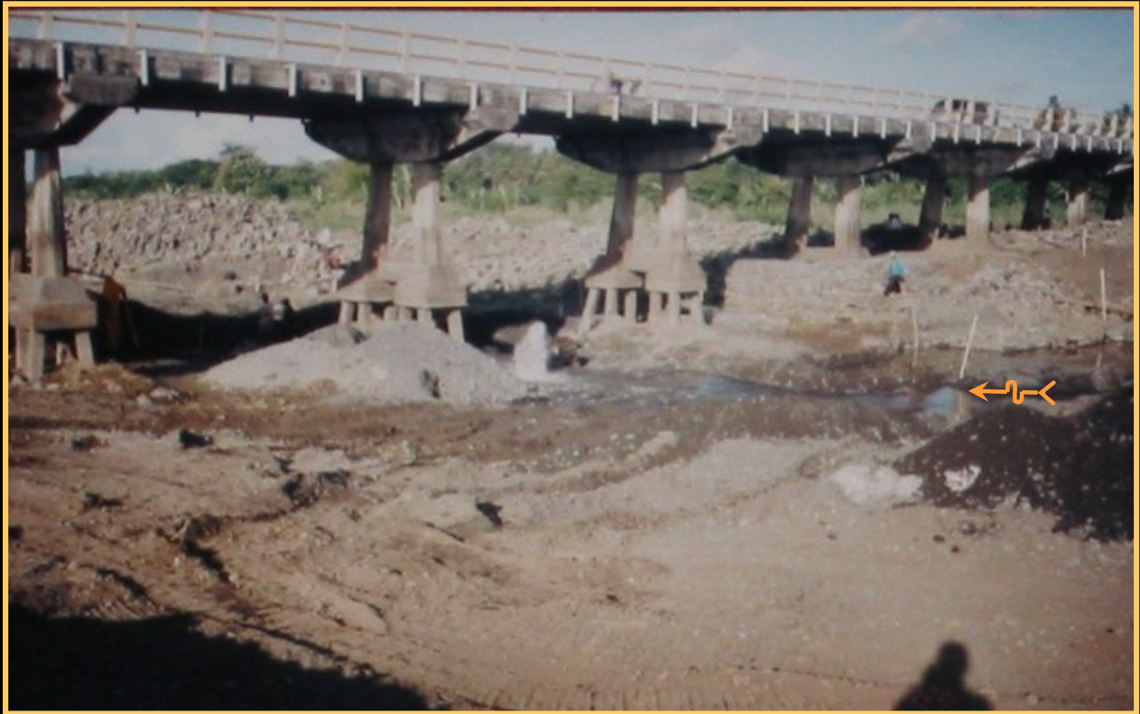
Usaha perlindungan pilar jembatan dengan selimut bronjong.
