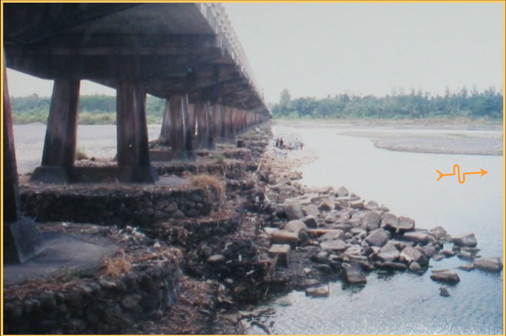
Selimut dan lantai hilir, konstruksi bronjong.
