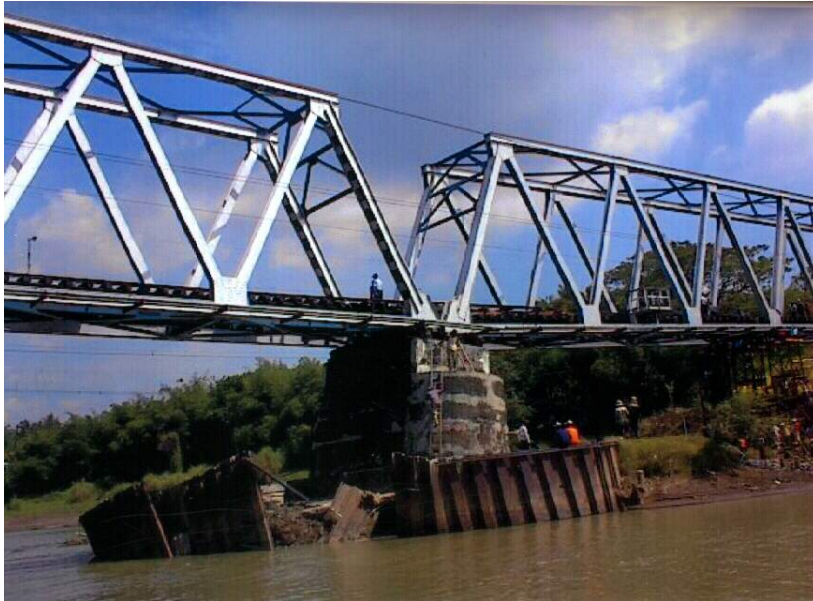
Jembatan KA Comal, Jateng (2002)
